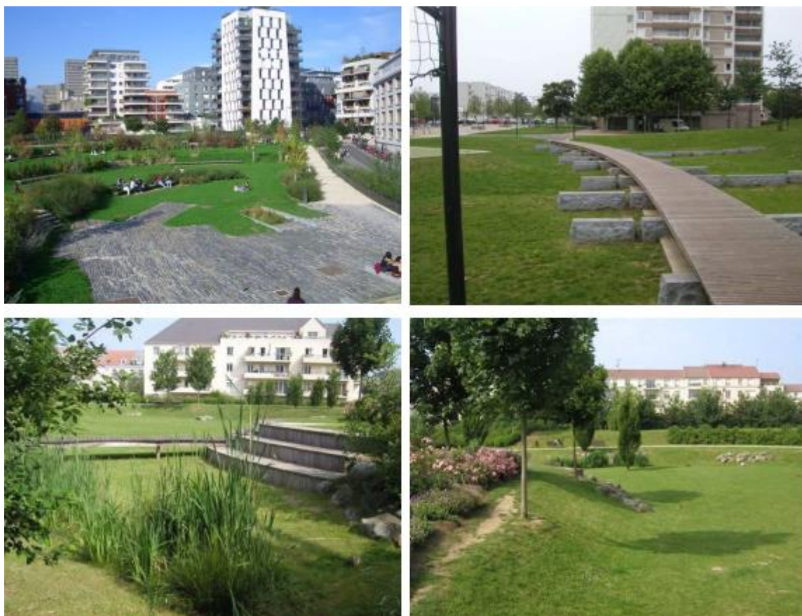
Figur 6: Exempel på utseende av torra dammar i parkmiljö. En temporär vattenspiegel byggs upp vid regntillfällena med hög avrinning.
