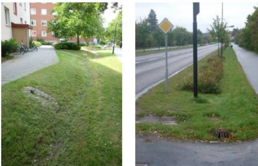
Figur 7: Exempel på svackdiken.
