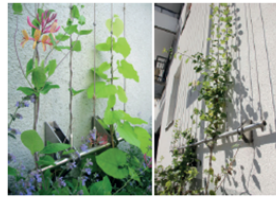
Våxtvåjrar Fasaden förses med våxtvåjrar på valda ställen för att skapa en mjuk kontrast till den perforerade plåten.
