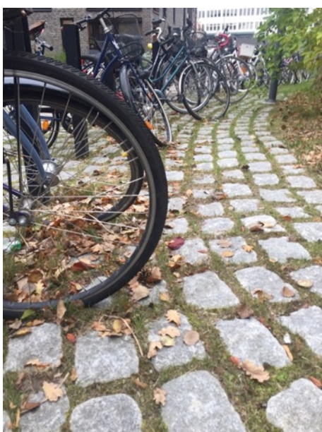
Figur 16, exempel på cykelparkering med marksten där dagvatten kan infiltreras i fogarna mellan stenarna. Foto Geoveta
