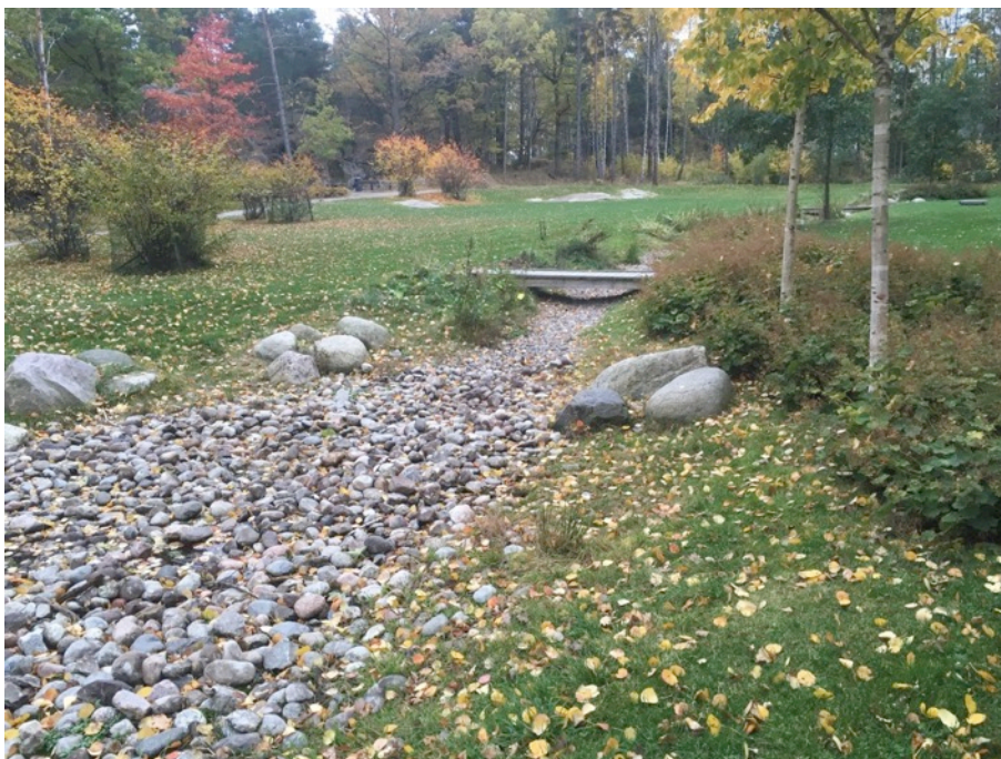
Figur 13. Exempel på krossdike i Sköndal. Foto: Geoveta
