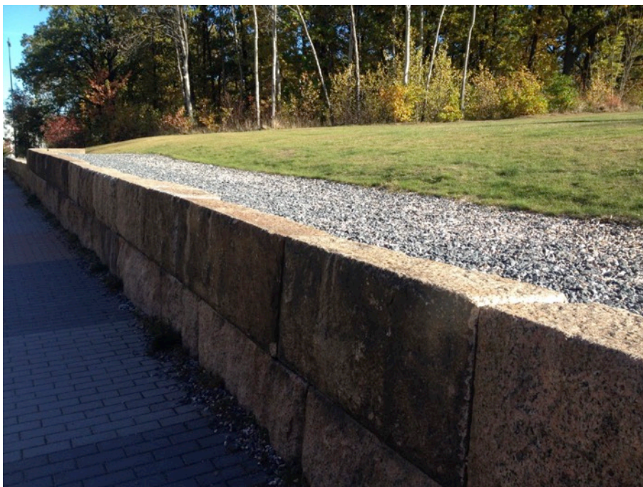
Figur 17, exempel på motfylld mur med grovt material som kan buffra dagvattenflöden. Foto Geoveta.
