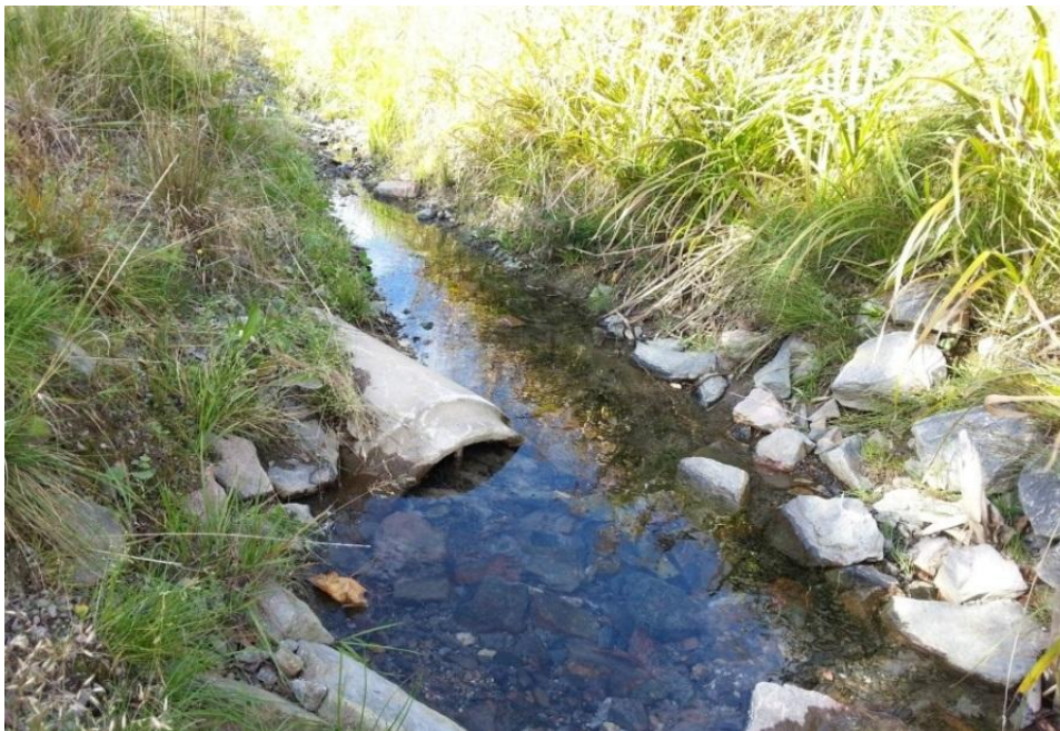
Figur 5. Utlopp från Vistaberg i vägdike utmed Rosenhillsvågen.
