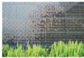
Princip Olika perforeringsgrad skapar olika fält på fasaden.
