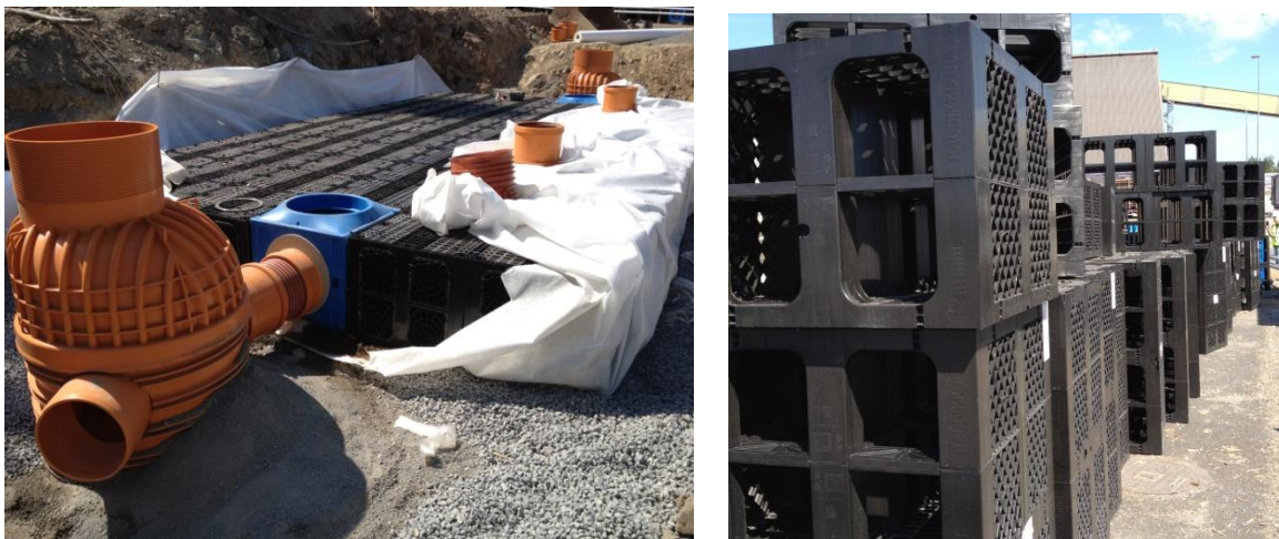
Figur 11 Sammankopplade dagvattenkassetter som utgör ett fördröjningsmagasin (vänstra bilden). Högra bilden visar hur en kassett ser ut.
