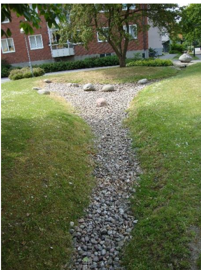
Figur 8: Ett exempel på ett makadamfyllt dike med reningsfunktion.
