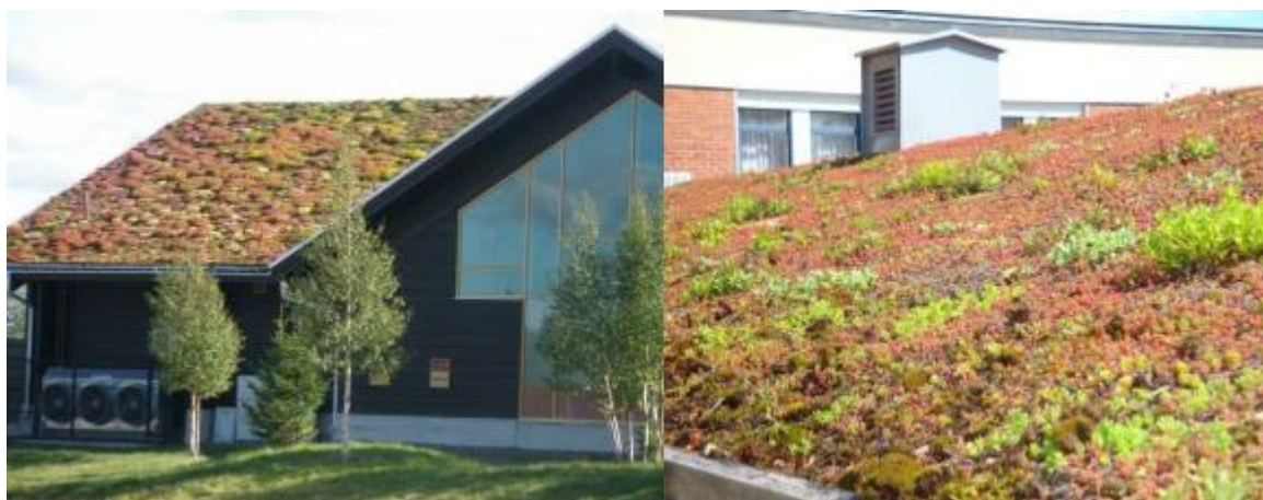
Figur 4: Exempel på hur en anläggning av gröna tak kan se ut
