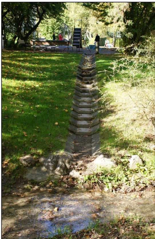
Figur 10 - Brant mindre dike som mynnar i större öppet dike.
