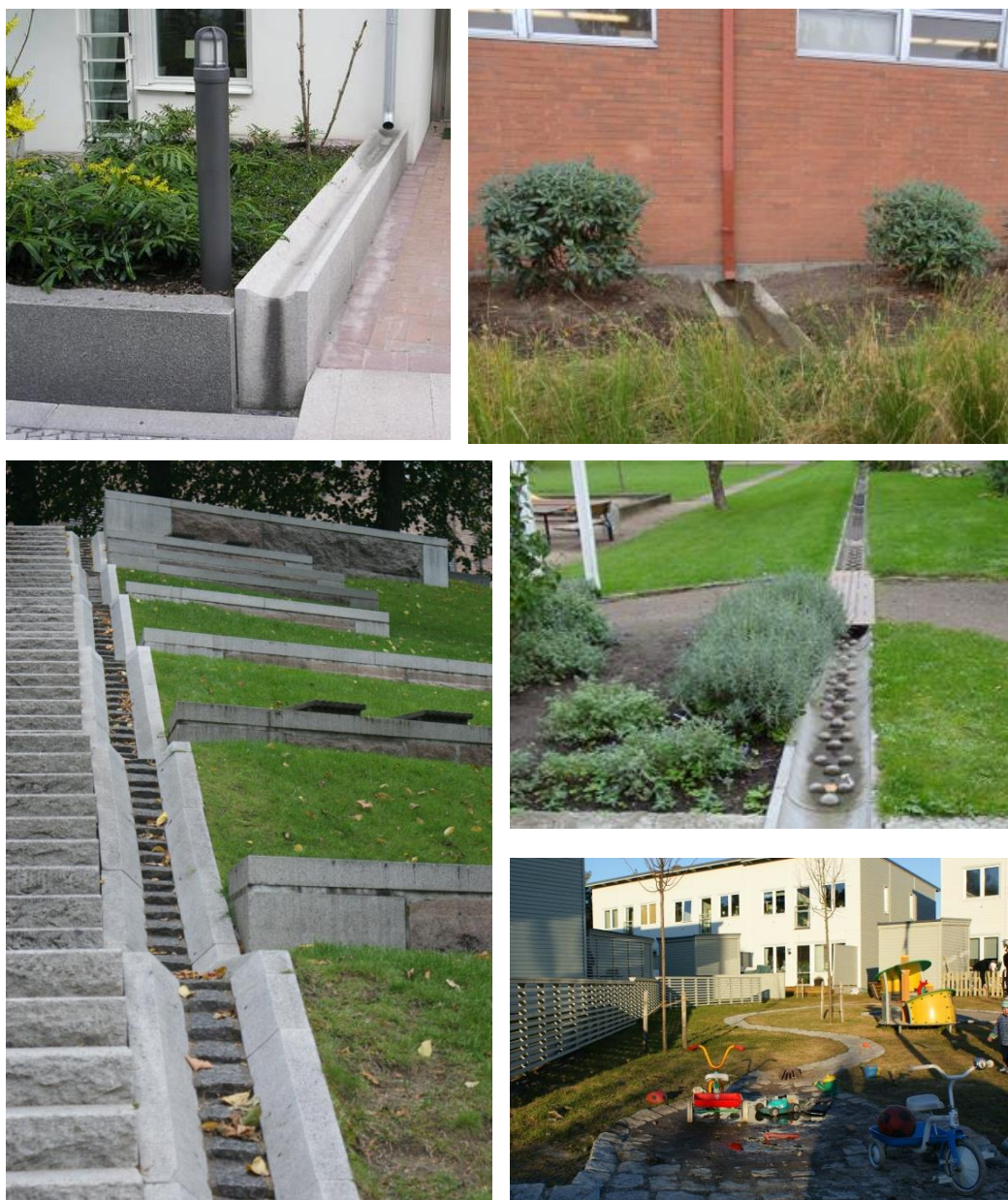
Figur 7. Övre bilderna ger exempel på stuprörutkastare som ansluter till rännor. Nedre bilderna visar olika typer av rännor och ytlig avledning.
