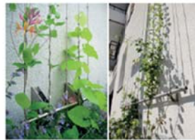
Våxtväjrar Fasaden förses med våxtväjrar på valda ställen för att skapa en mjuk kontrast till den perforerade plåten.
