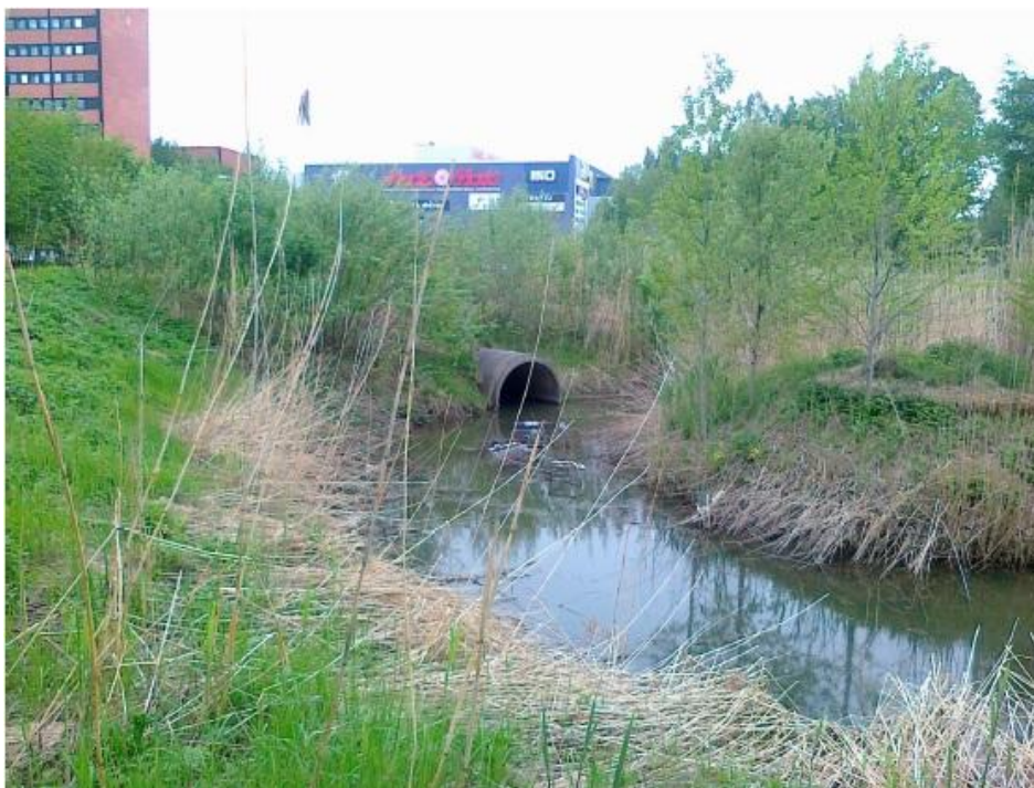
Figur 11. Befintlig damm i västra Kungens kurvas delavrinningsområde där Segmentet 1 ingår. Foto mot väster och Dialoggatan. Bebyggelsen på Diametern 2 till vänster i bild. Bilden är hämtad från Dagvattenhantering Diametern 2 – Kungens Kurva, Tyréns 2013-09-12 . Planområdet
