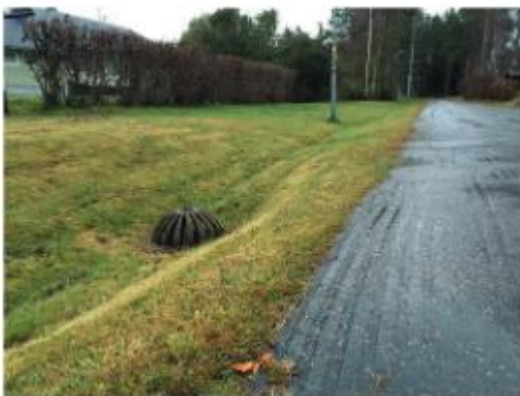
Exempel på ett svackdike med dagvattenbrunn.
