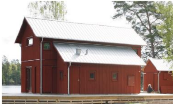
Falsat plåttak/ pannplåt
