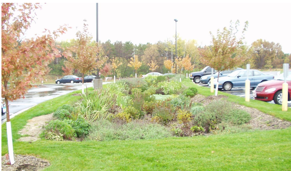
Bild 9. Exempel på Rain garden i anslutning till parkeringsyta. Källa: Beskuren bild från cleanwatermn.org
