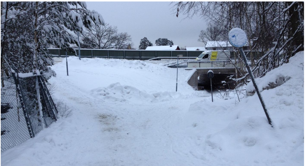
Bild 3. Vy från vändplatsen längst ner på Furuvägen mot Häradsvägen. Till vänster i bild syns fastighetens östra hörn, där marknivån är som lägst
